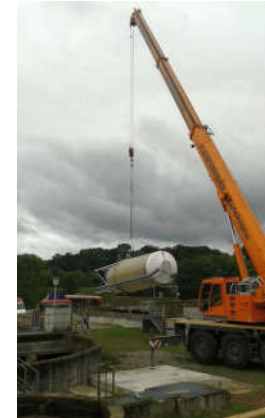
Mit dem Kran weiter auf dem Weg zum Fundament.
